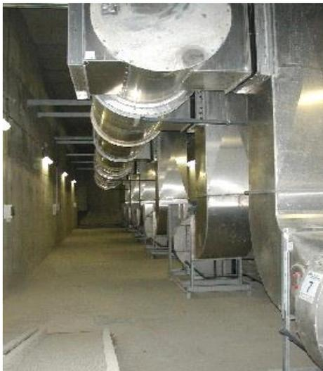
L'aria immessa nel materiale, attraverso gli ugelli insufflatori e filtrata, attraverso la matrice organica, viene ricircolata e miscelata con aria "esterna" nel caso che siano richieste variazioni delle condizioni di temperatura e/o % di ossigeno all'interno del tunnel.
